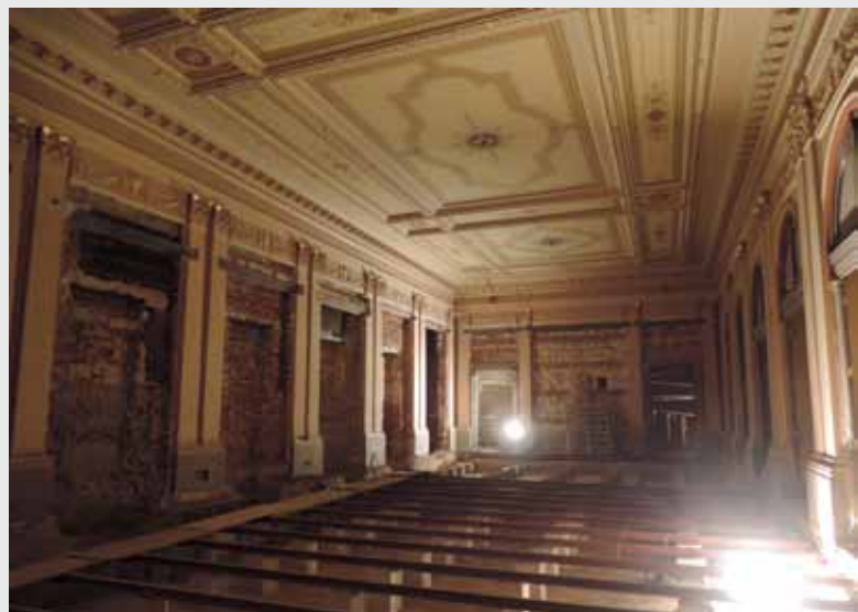
▼ Obr. 6. Pohled na nově vytvořené niky (zdroj: AVETON s.r.o.)
