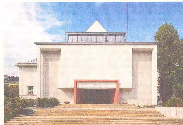
Rekonstrukce Domu umění města Brna Jiřího Hruši si získala nominaci na Grand Prix Obce architektů v roce 2010. FOTO ARCHIV
